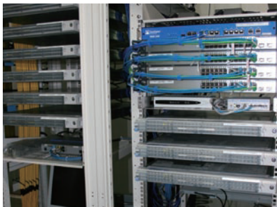
IP告知放送システムのセンター設備
